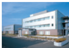
技术综合中心
